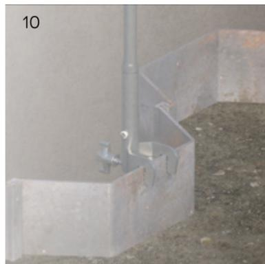
Halterung für Stahlkonstruktion
